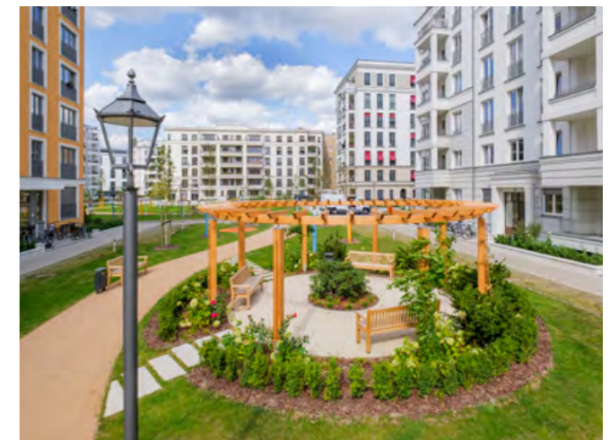
BOX SEVEN, Stadtquartier, Weser-/Holteistraße, Boxhagener Straße, Berlin-Friedrichshain, 424 Mietwohnungen, 191 Eigentumswohnungen, gewerbliche Nutzung ca. 10.900 m 2 / BOX SEVEN, urban district, Weser-/Holteistraße, Boxhagener Straße, Berlin-Friedrichshain, 424 rental apartments, 191 apartments, commercial use approx. 10,900 m 2
