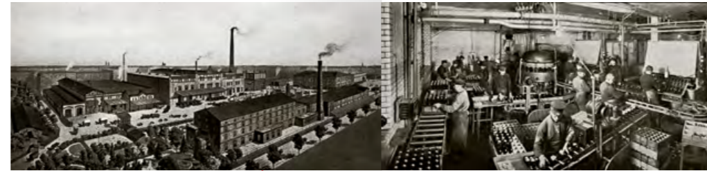
1913 Flaschenabfüllanlage und Produktionsgelände / Bottle filling plant and production site
